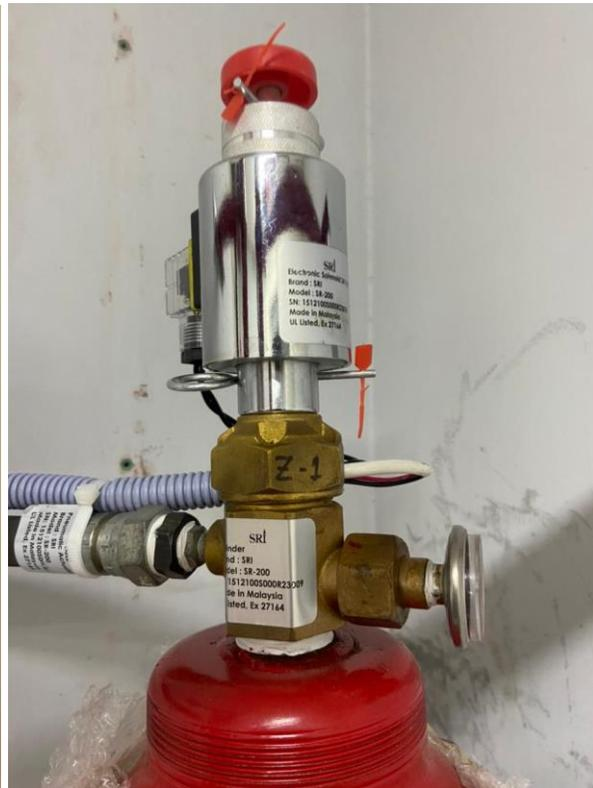
2. Los sistemas extintores con agente limpio que llevan marcas de certificación UL **autorizadas**, que **no** se cubren en este aviso, se muestran en las siguientes fotografías y se proporcionan con propósitos de comparación:
